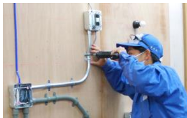
35組 岩田さん(電気工事)
